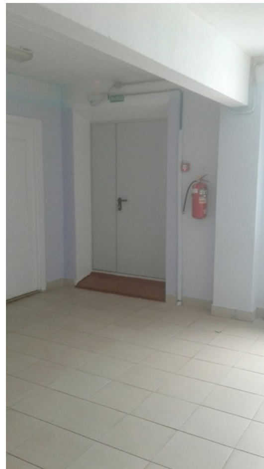
Ремонт путей эвакуации МАОУ «Уральская основная школа»
