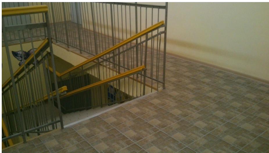
Ремонт путей эвакуации МБДОУ «Савинский детский сад «Созвездие»
